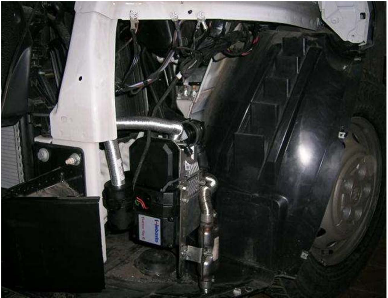
Месторасположение блока Webasto в моторном отсеке автомобилей.
